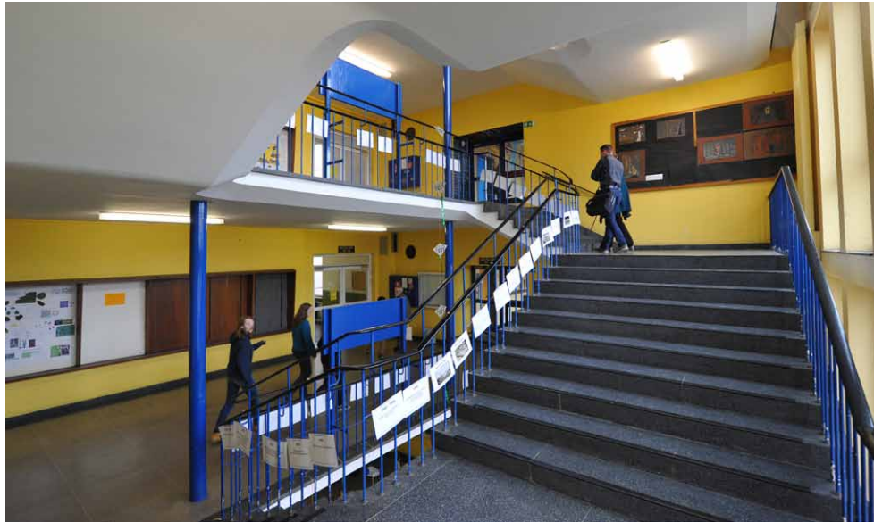
Das zentrale Treppenhaus
