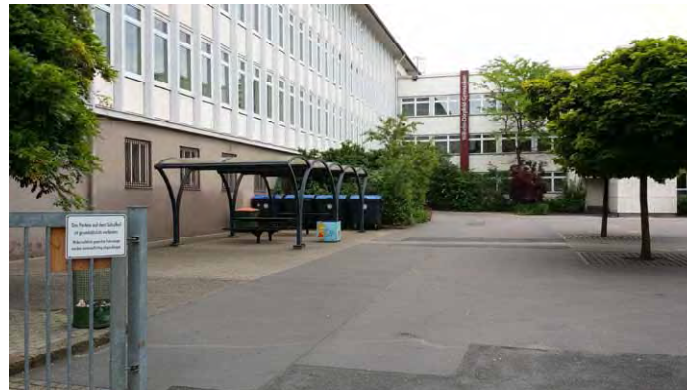
Eingangsbereich, links am Gebäude Eingang des geplanten Stadtteilcafés Bildmitte. Nicht erkennbarer Haupteingang
