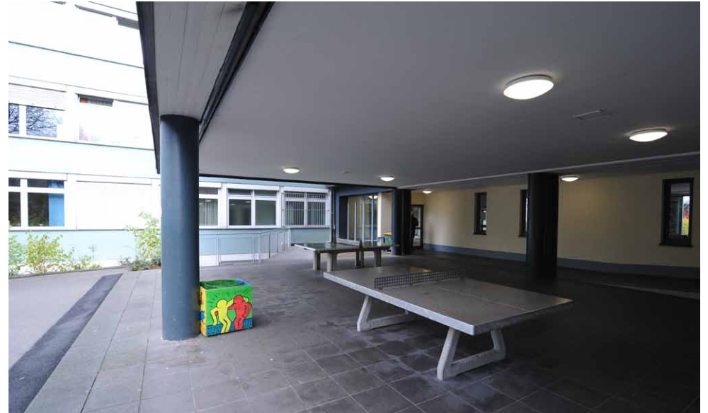
Überdachter Eingangsbereich vom westlichen, tiefer liegenden Schulhof
