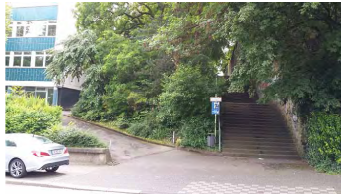
Links: Zufahrt zu den Stellplätzen, geplanter Eingang des Multifunktionsraumes, rechts: historischer Treppen-Aufgang zur Stadthalle
