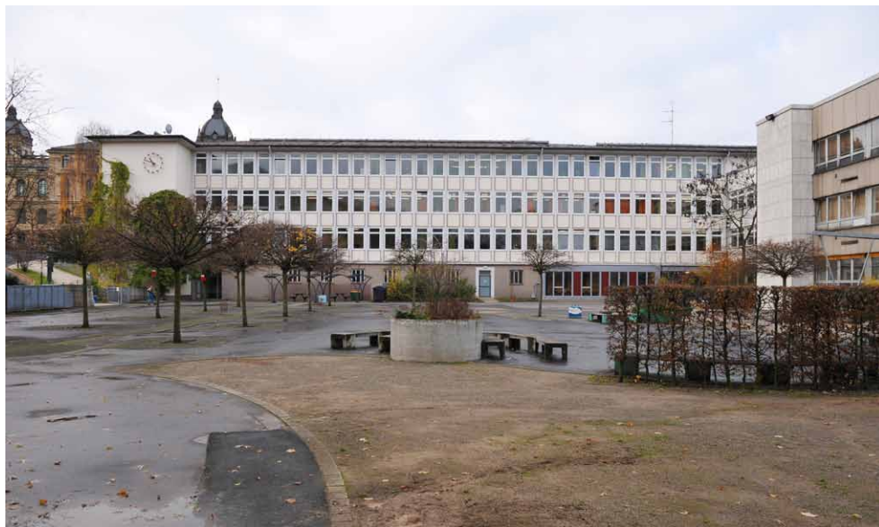
Östlicher Schulhof mit der charakteristischen Fassade des Südflügels
