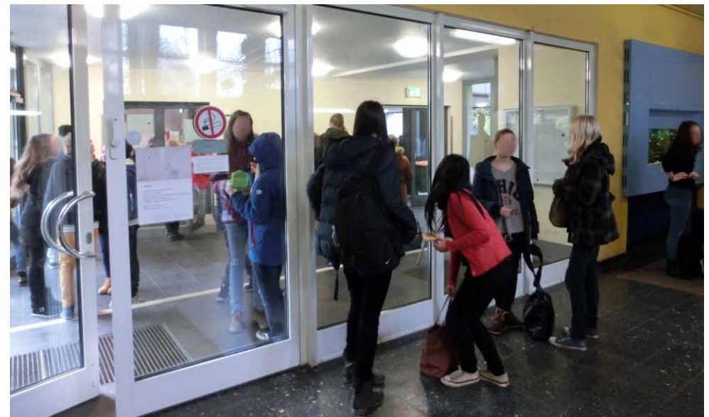
Verbindungstür vom Windfang zum zentralen Treppenhaus
