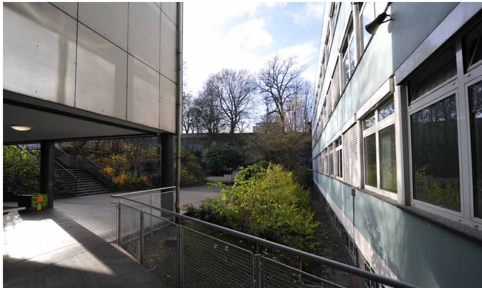
Blick vom westlichen Eingang auf den Geländeversprung des westlichen Schulhofes
