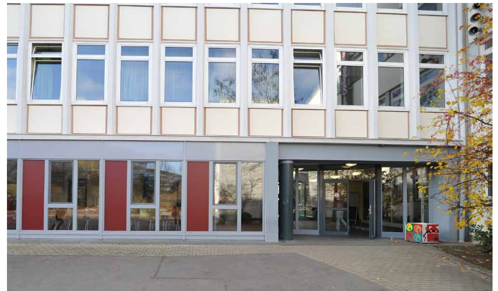
Zurückgesetzter Haupteingang vom westlichen Schulhof, links vom Eingang die Mensa
