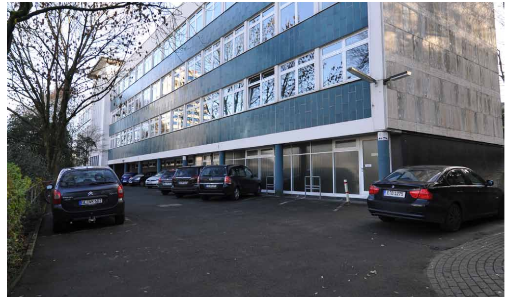
Einfahrt / Zugang von der Südstraße zu den Lehrerparkplätzen
