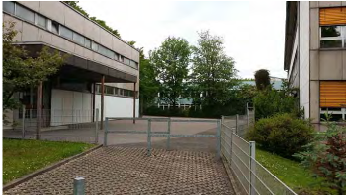
Barrierefreier Eingangsbereich von der Straße Johannisberg
