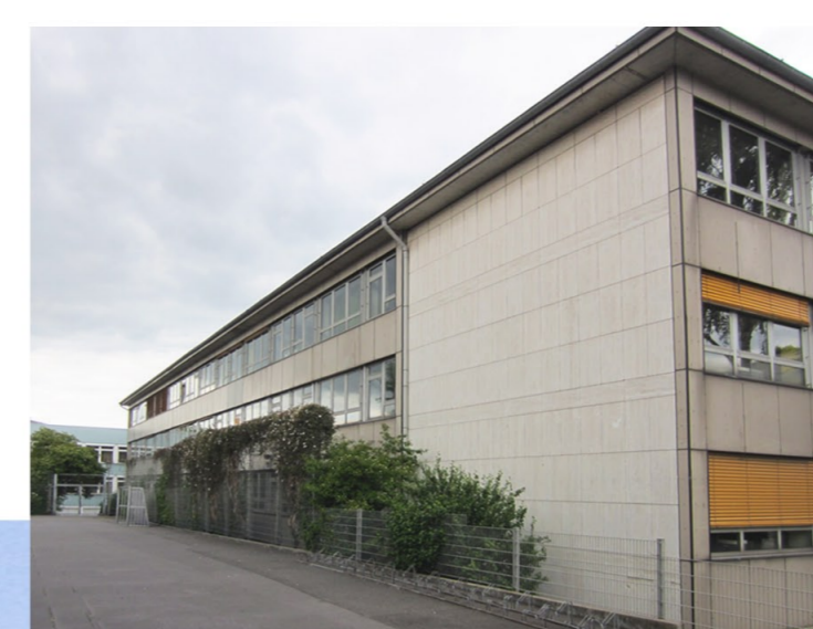
BLICK ENTLANG DER WESTFASADE
