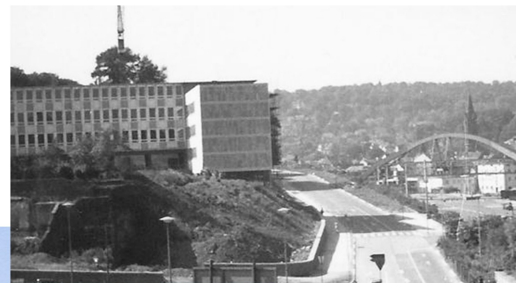
BAUPHASE: BLICK ENTLANG DER B9
