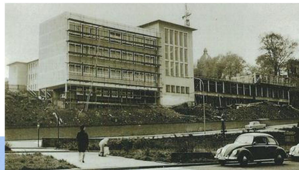
BLICK VOM HEINRICH-KAMP-PLATZ [BAUPHASE]
