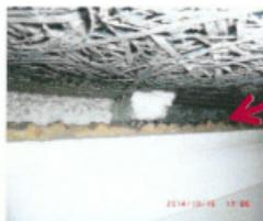
Anschluss Sturz : PU-Schaum/Styropor/KMF-Schnur/asbesthaltige Kitt-Masse
