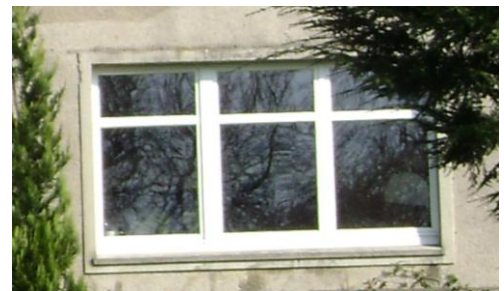
Walmdach mit Dachgaube Beispiele der ursprünglichen Fensteraufteilung,
