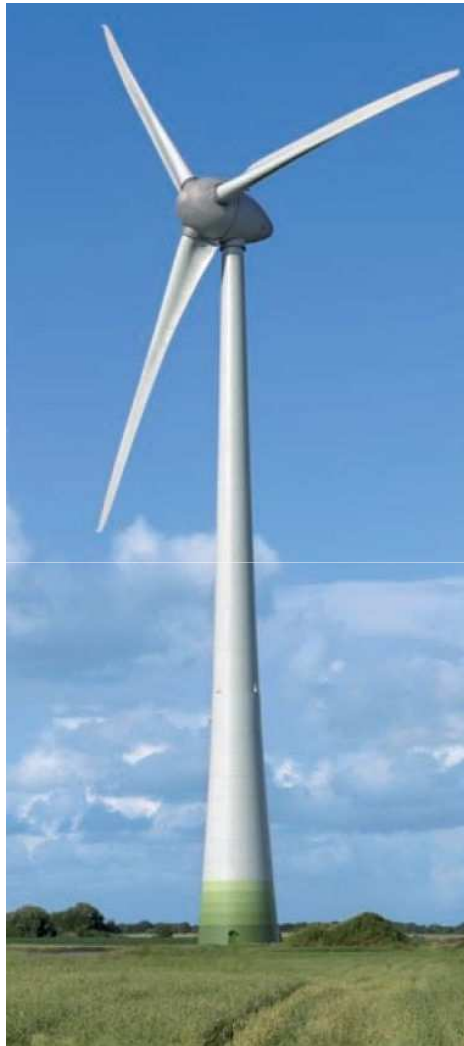
1 Windkraftanlage (2,3 MW) 179 m Gesamthöhe
